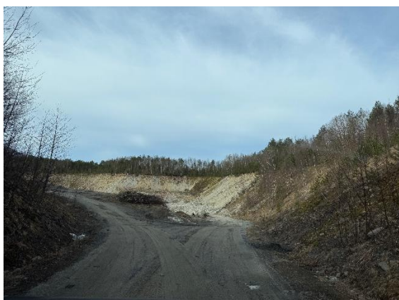
Figur 2 Bilde fra masseuttaket tatt 09.04.26
