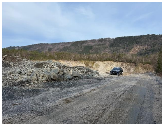
Figur 3 Bilde fra masseuttaket tatt 09.04.26
